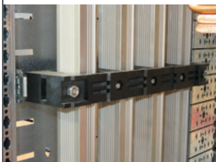
Вставьте шины и затяните суппорты чтобы шины прочно удерживались на месте (момент затяжки указан на стр. 27).
