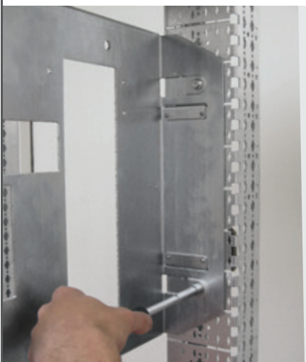
Крепление пластины с помощью винтов М6 и клипс
