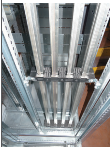
Вставьте шины и затяните суппорты чтобы шины прочно удерживались на месте (момент затяжки указан на стр. 27).
