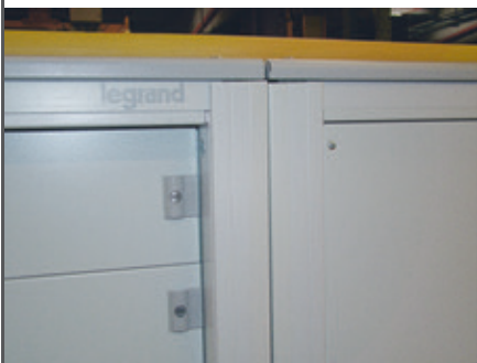
Безукоризненная облицовка двух объединенных шкафов.
