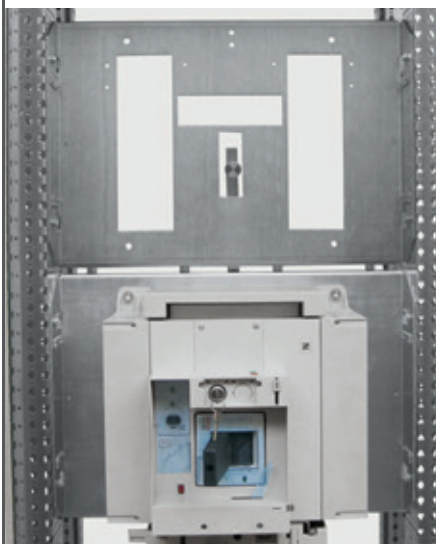
Устройство ввода резервного электропитания на основе DPX 3 1600
