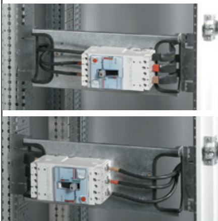
Аппарат на пластине можно установить вводными зажимами вправо или влево.
