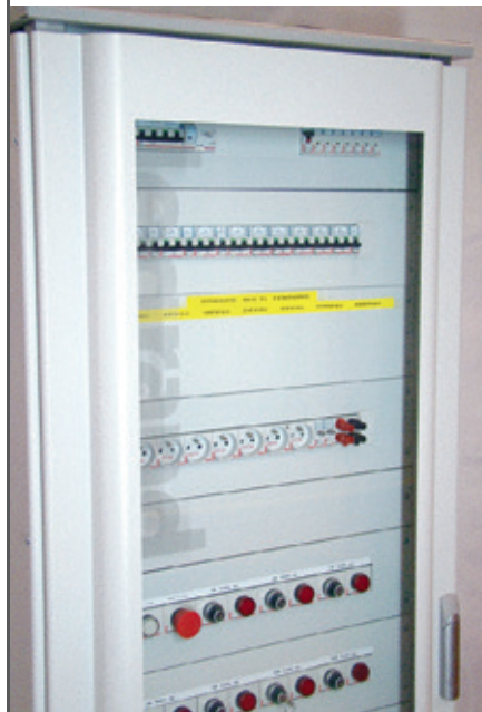
Степень защиты IP 55 достигается установкой двери (за исключением установки на кабельной секции).
