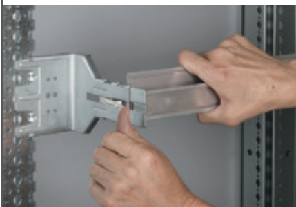
2 – Закрепите монтажную рейку в одном из двух положений.
