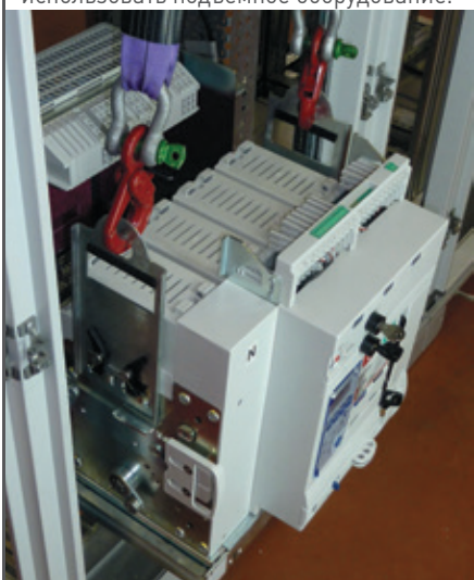
Установка выкатного DMX 3 в корзине
