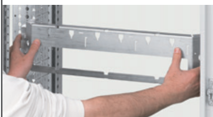
Разместите монтажную пластину в нужном положении.
