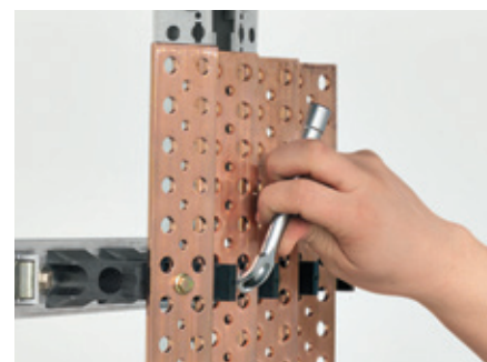
Прикрепите медные шины к суппорту (момент затяжки 7 Н·м)
