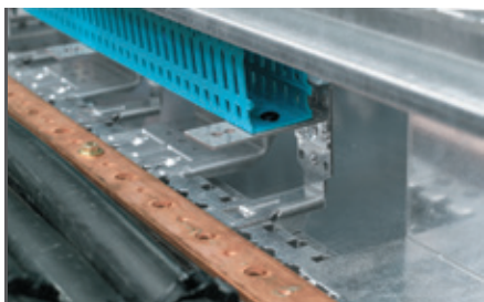
Лоток крепится на суппортах пластиковыми заклёпками из комплекта.
