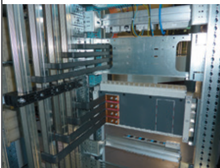
Комплект для подсоединения переда- точных шин поставляется в разобранном виде
